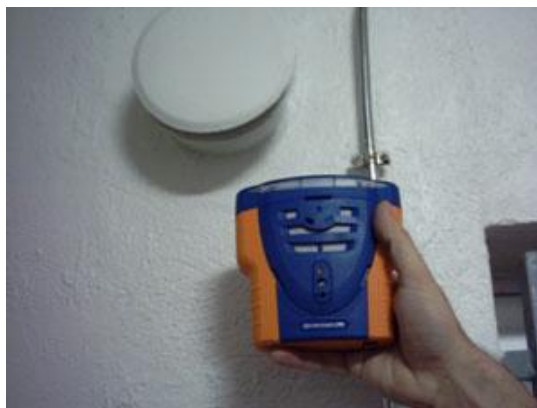
Controllo di un'uscita di gas con il rilevatore di gas Tetra.
