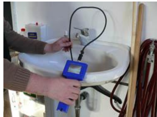
Osservando un intasamento in una tubatura
